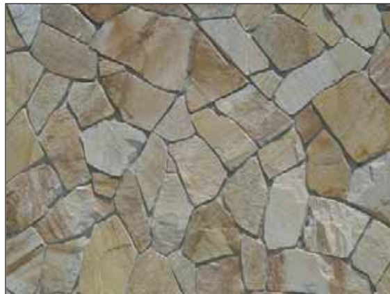
Opera incerta spessore cm 1,5/2,5. Posa in opera senza fugatura
