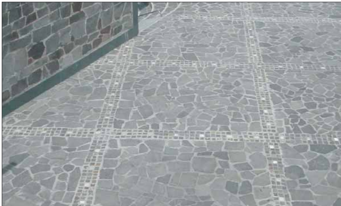
Opera incerta spessore cm 2/5 scandita da una trama regolare di cubetti tipo 4/6 cm di porfido e bianco Carrara
