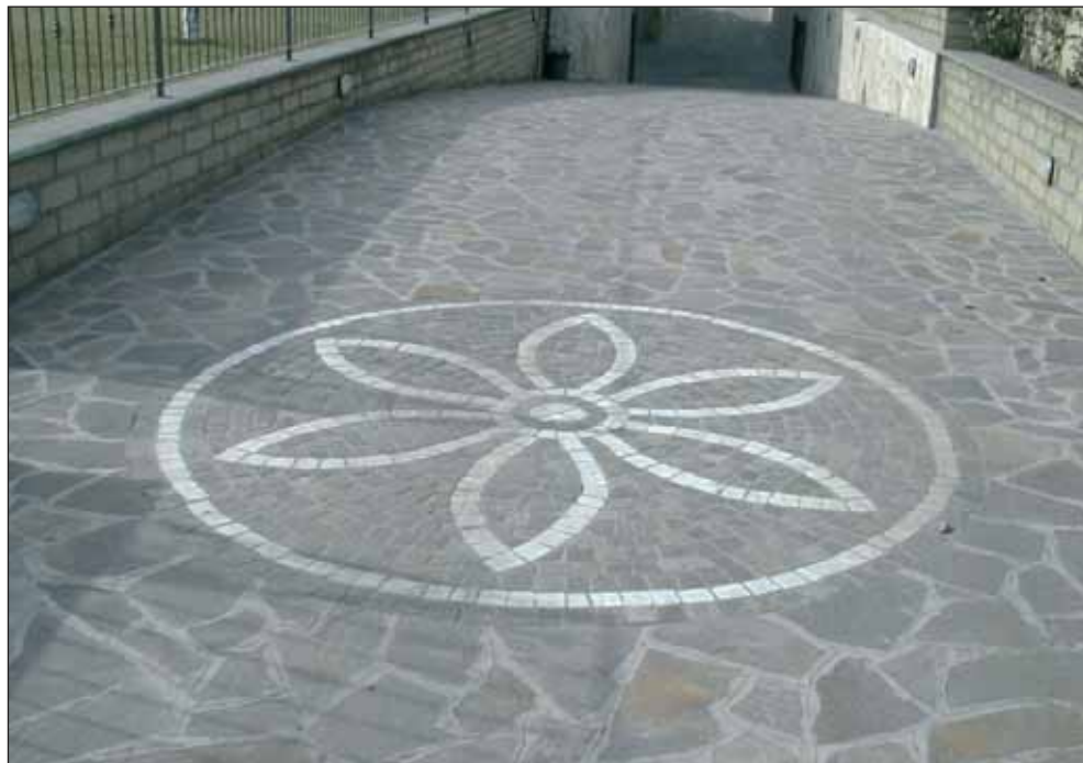
Fiore realizzato con cubetti di Carrara tipo 4/6 cm inserito in opera incerta. Spessore 2/5 cm
