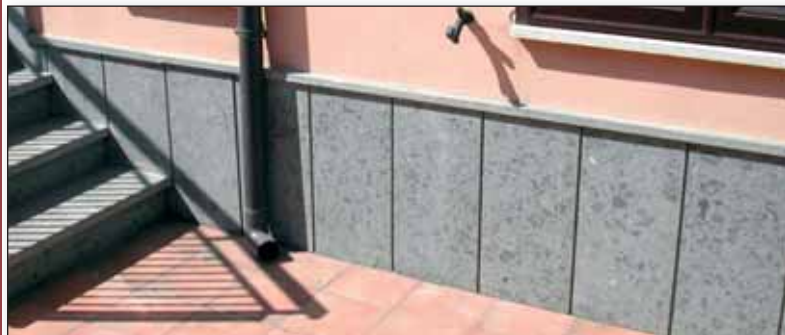
Rivestimento 30x60x2 con canaletto
