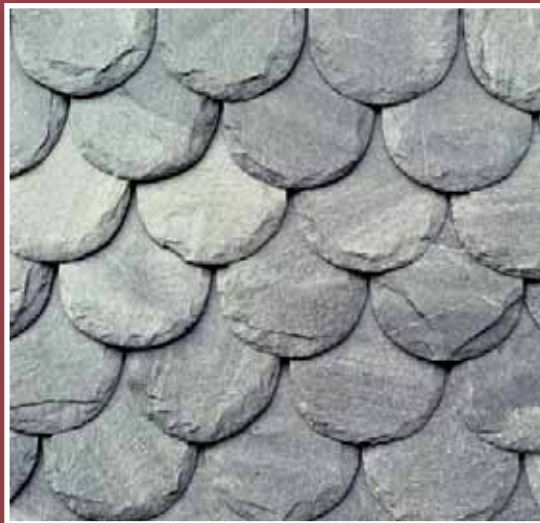
Copertura alla Svizzera (squama). Dim. lastre cm 30x40
